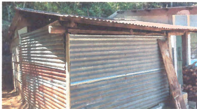
Foto 2: Reparación y mejoramiento general de cocina.
