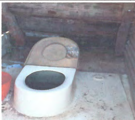
Foto 3: Mejoramiento general de sanitario y fosa séptica
