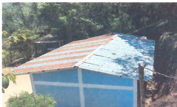
Foto 4: Mejoramiento y estructura de techado.
