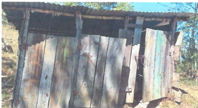
Foto 1: Mejoramiento general de sanitario y fosa séptica
